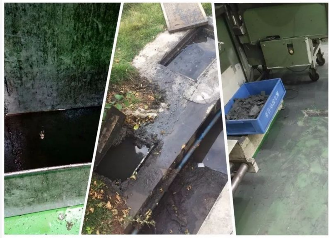
Ölflecken, Staub und Dreck sind überall in der Fabrik
