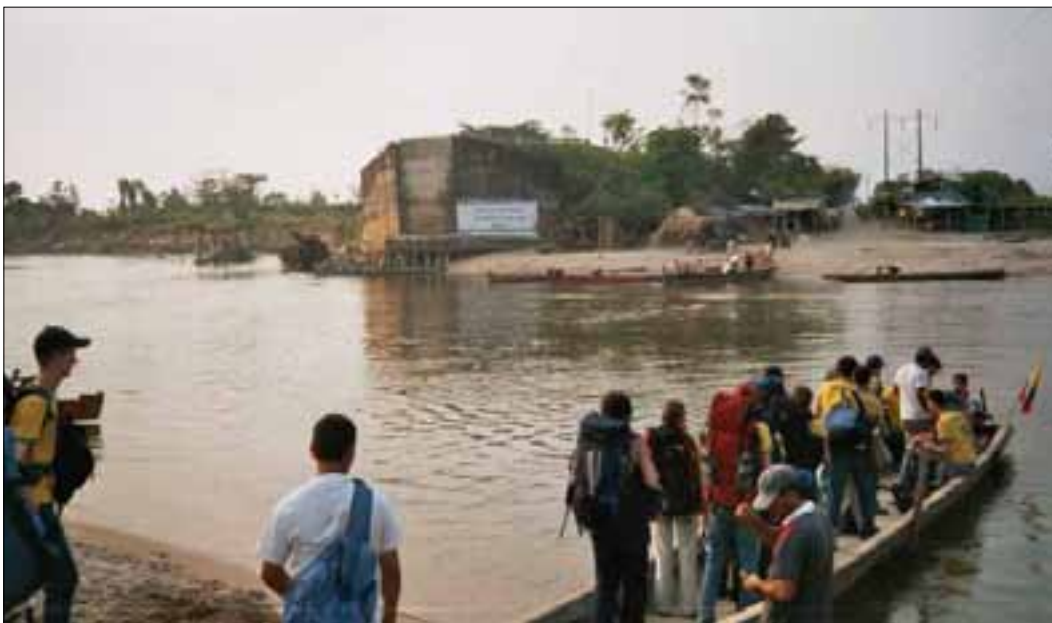
Eine Fähr-Kooperative betreibt den »Ersatzverkehr« für eine zerstörte Brücke in Arauca
